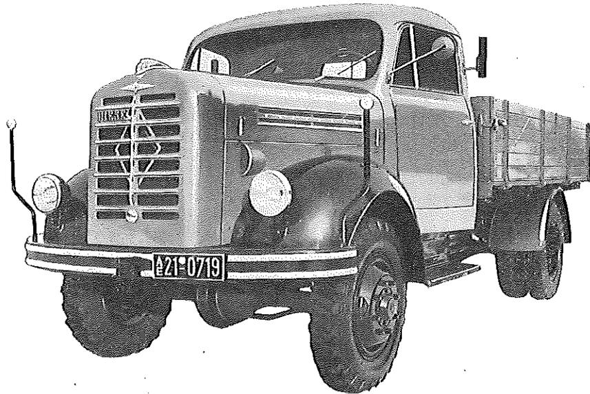
**Diesel-Motor · 6 Zylinder · 4-Takt · 110 PS bei 2800 U/min**
